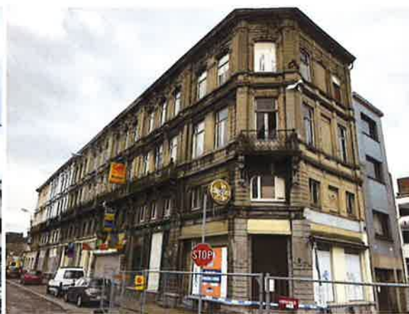
Photo 2 : Angle du bâtiment
