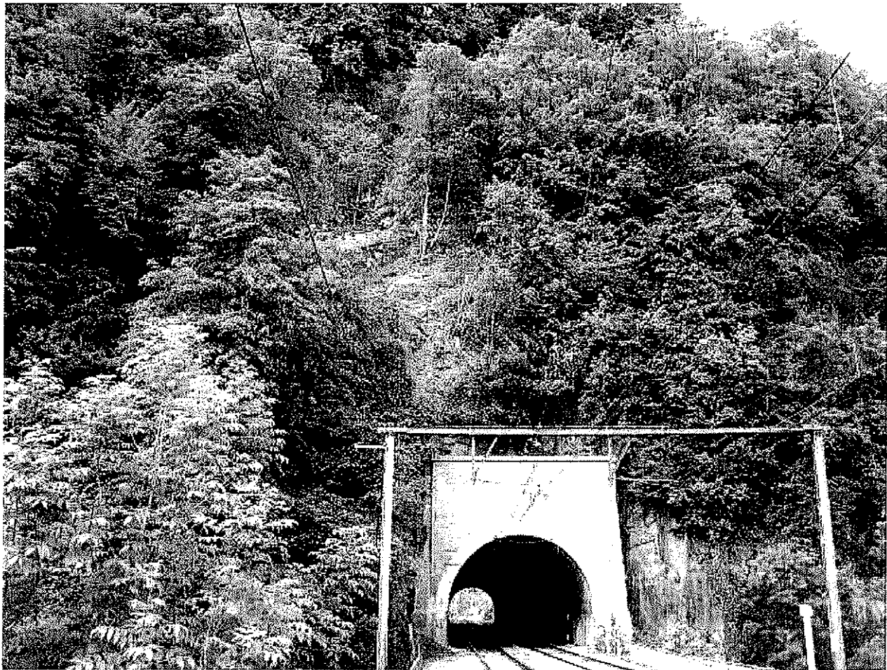
Figure 5. Photo 59-1, vue d'ensemble.
